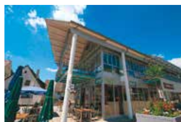
Die Kanzlei in Hösbach
